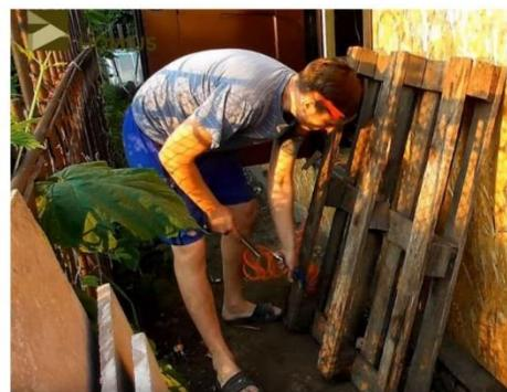
**2.** Далее перемещаемся в мастерскую. Скрепляем все стыки конструкции минимум тремя саморезами с одной и другой стороны. Здесь из опыта скажу, не экономьте на материалах.
