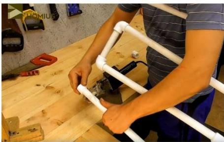
**8.** Проверяем прочность стыков и соединений. Одну сторону закрываем заглушкой.
