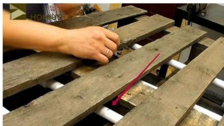
**11.** В местах, некрытых досками последовательно просверливаем ряд отверстий (не насквозь трубы, только с одной её стороны) для выхода воды.
