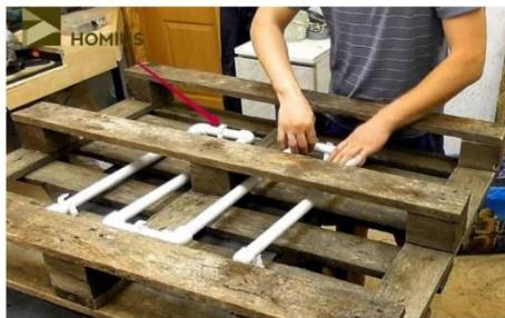
**10.** Делаем метки на тех участках трубы, которые выступают наружу. Причём сверлить лучше всего ступенчатым сверлом: оно и отверстие сделает и фаску снимет. Удаляем трубу из поддона.
