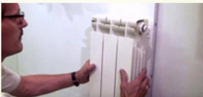
Далее размечают и закрепляют в нужных местах *радиаторы*. Здесь наглядно изображен пример, как подключить электрокотёл в систему отопления на небольшом демонстрационном стенде. В действительности надо будет установить все приборы, залить стяжкой тёплые полы.
